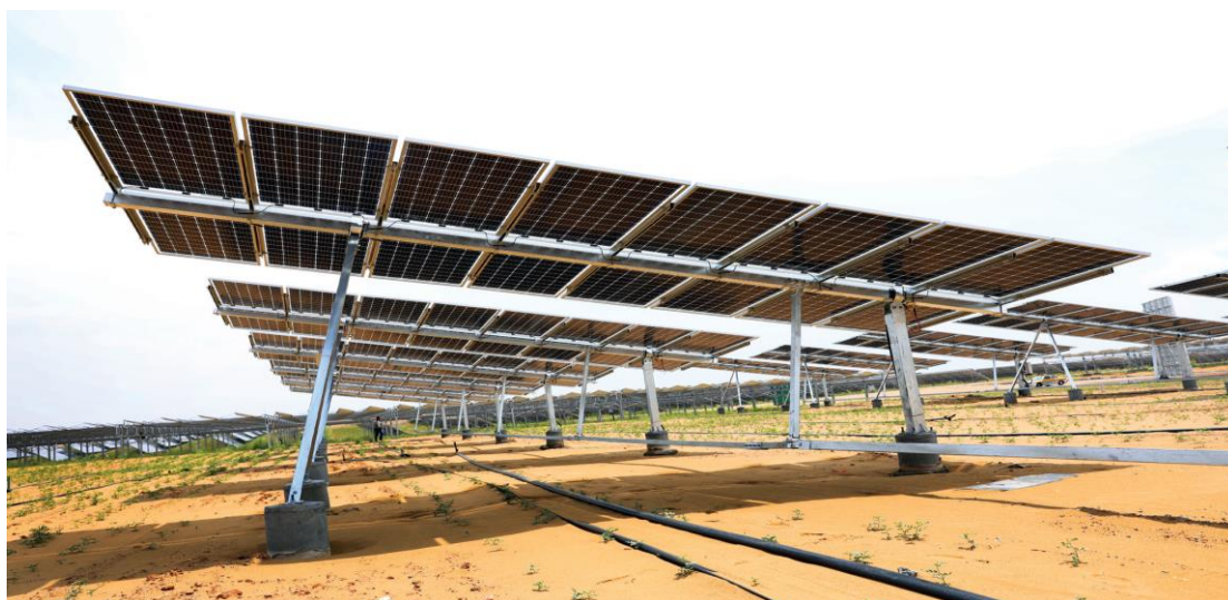
Abbildung 11 Skizze der Installation des bifazialen Moduls
